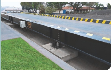
Balança sobre o piso
