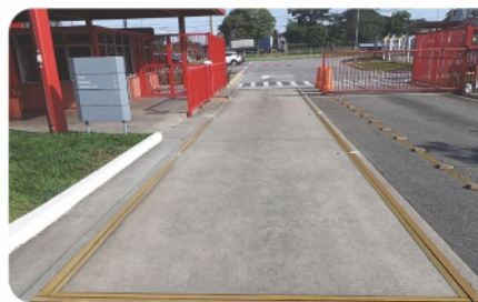
Balança embutida com fosso
